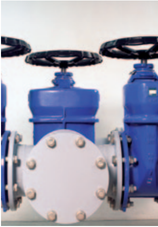
Rennsteigtunnel Zella-Mehlis, Germany 52 VAG BETA® 200 Gate Valves
